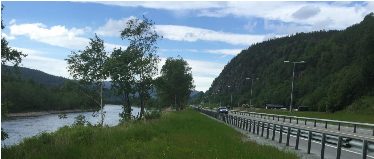
Figur 45. Utvidelsen av dagens E6 vil ved Håggån gjøre dyrs passasje langs elva svært vanskelig da veien i praksis går helt ut til elvekanten.
